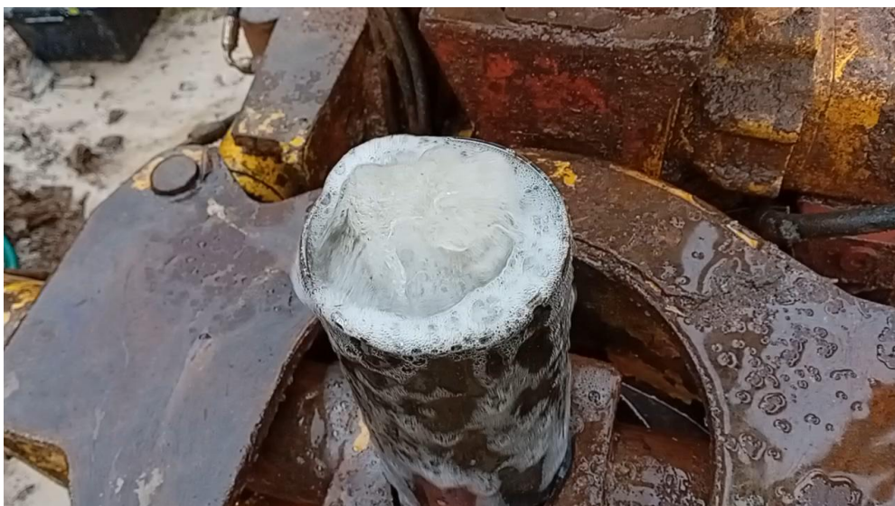
Obr. 2 Výrony plynu v podzemní vodě vrtu PHJ31 v průběhu vrtných prací (foto Filip Šmat) Fig. 2 Air-bubbles flow during drilling of borehole PHJ31 (photo Filip Šmat)
